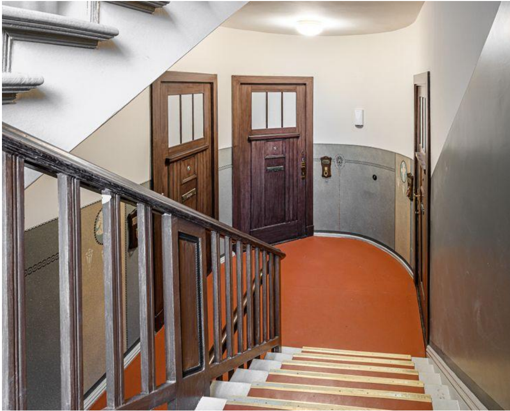
Saniertes Treppenhaus Cas2A
